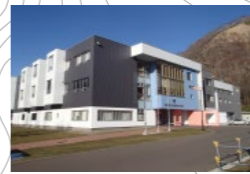
23 知床未来中学校 洪 潮 地 津 約71m
