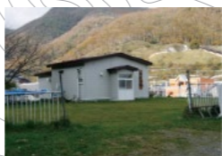
18 緑町町内会館 洪 土 潮 地 津 約19m
