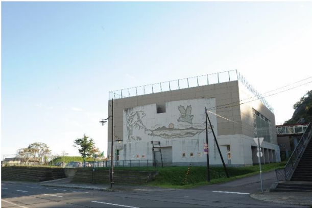
羅臼小学校体育館外壁
