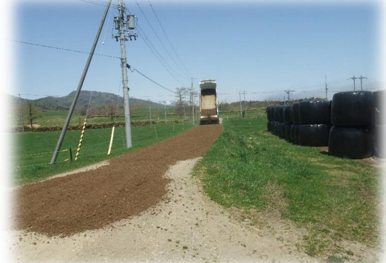
協定農道の補修
