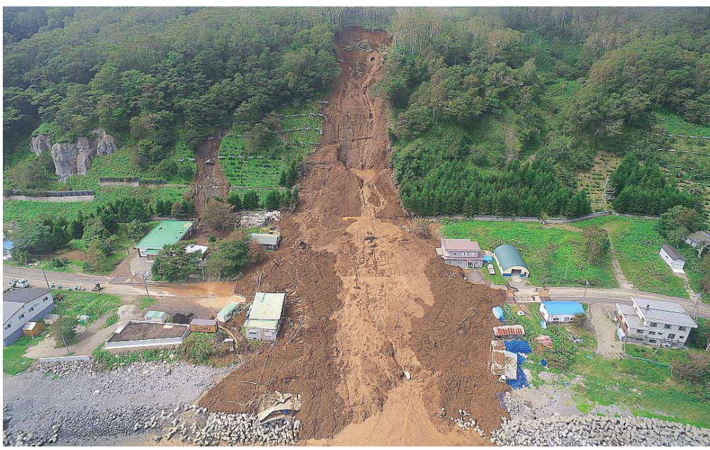
▲長期間に及んだ降雨の影響で崩落し町が寸断
