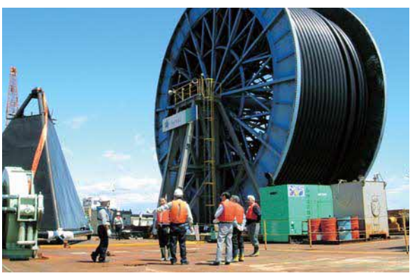
▲海洋深層水取水管敷設時の様子
