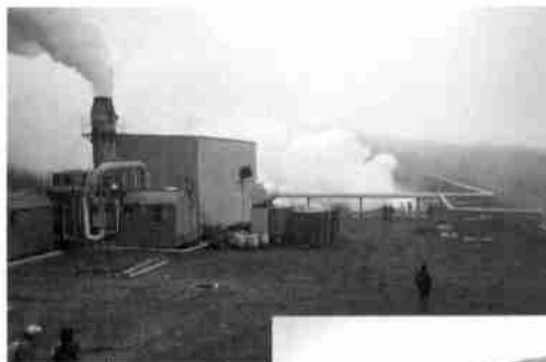
択捉島の地熱発電所。着々と社会基盤整備が進められている。(2008年9月撮影)
