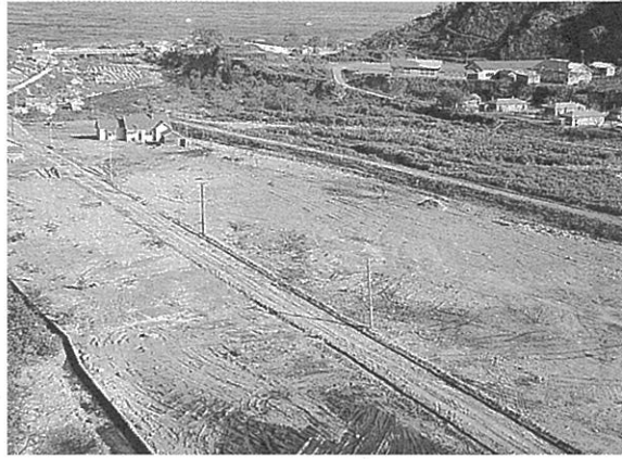
昭和三十三年羅臼川左岸の土地造成
