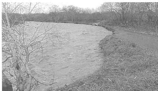
植別川増水による道路決壊の様子 (平成24年11月8日撮影)
