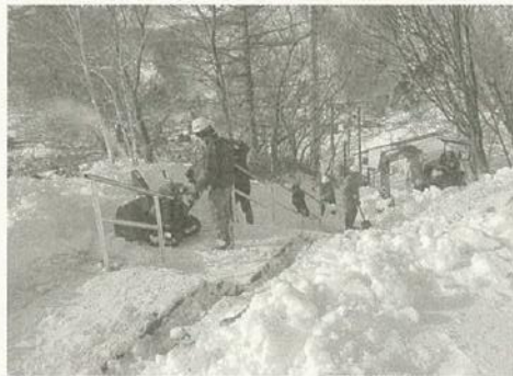
羅中通学路階段除雪作業
