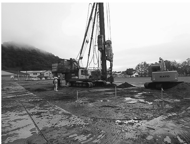
羅臼中学校グラウンド敷地内で始まった基礎関連工事 (杭打ち作業) H28.9.1撮影
