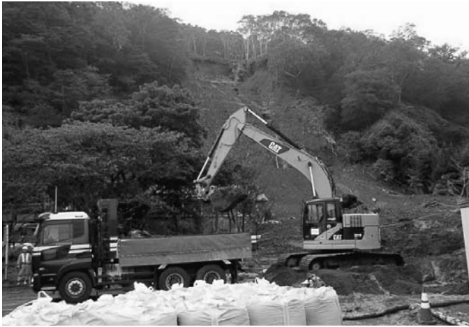
27日から始まった土砂搬出作業 釧路建設管理部中標津出張所 提供
