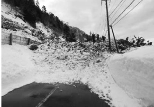
平成27年3月21日発生 相泊地区土砂崩れ
