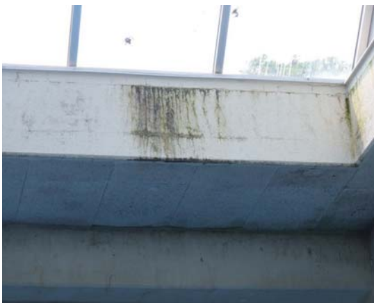
写真3. 温水プールの屋上で多数のオオセグロカモメが営巣し、巣作りのためコーキング材をはがし、その隙間に雨水が流れ込み、染み出している様子
