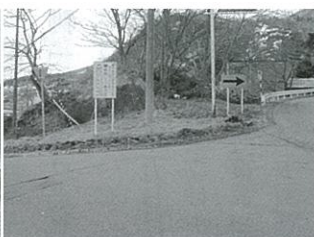
無線共聴施設設置工事 2,188万円 (ギャップフィラーアンテナ) 受信範囲：共栄町・礼文町の一部
