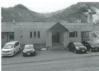
給食センター補修工事 3,062万円
