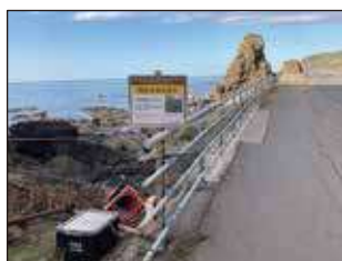
電気柵の 新規 設置
