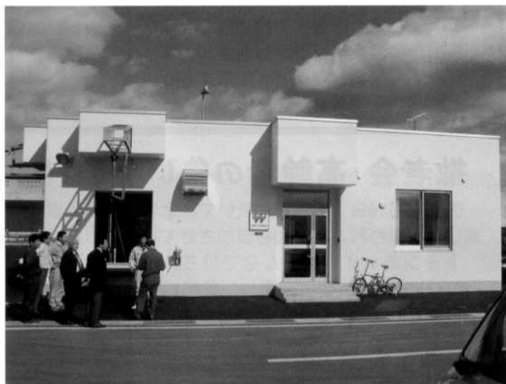
深層水給水施設外観
