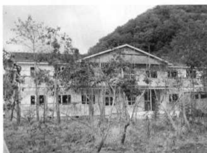
建設中のグループホーム
