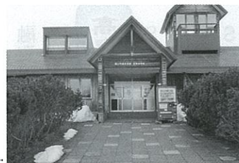
農林漁業体験実習館 多目的トイレ・スロープ新設工事 865万円
