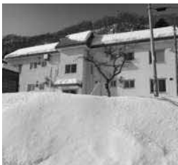
職員住宅改修工事(1棟4戸) 429万円 共栄町高校教員住宅を購入し内部改修を行う
