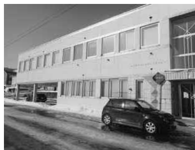
船見町コミュニティセンター改修工事 1,086万9千円 (屋根防水工事・内部天井等の補修を実施。管理主体が漁業協同組合から町に移管されました。)
