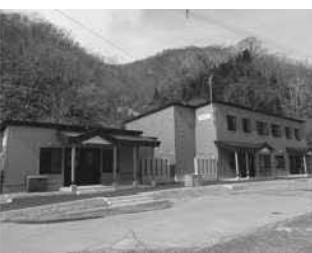
町営住宅等長寿命化工事 8,499万円 緑町団地Bブロック建替・合併 浄化槽の設置等
