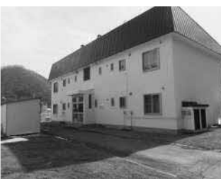
職員住宅改修工事 486万円
