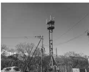
防災行政無線デジタル化整備工事 3億3,470万円
