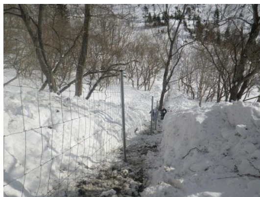
平成 23～26 年度に整備されたヒグマ・エゾシカ侵入防止対策事業
