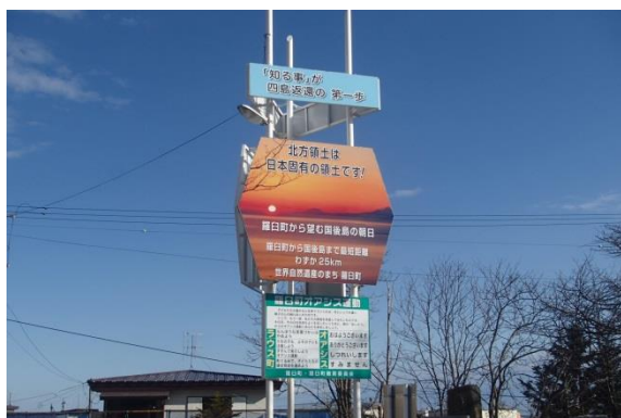
公民館駐車場北方領土啓発看板修繕
