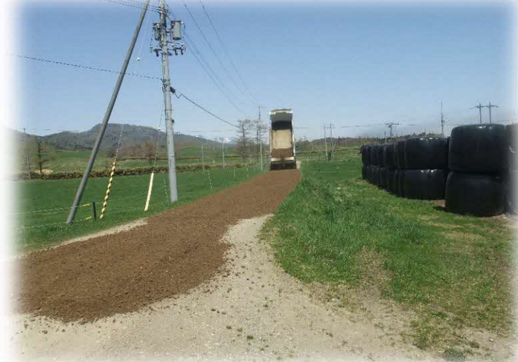
協定農道の補修
